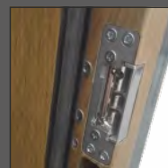
ELEKTROZACZEP ZAMONTOWANY W OŚCIEŻNICY TERMO ODS56 i TERMO ODS68
